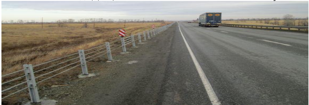
Рисунок 60. Пример установки тросового ограждения на обочине (применения на дорогах общего пользования)
