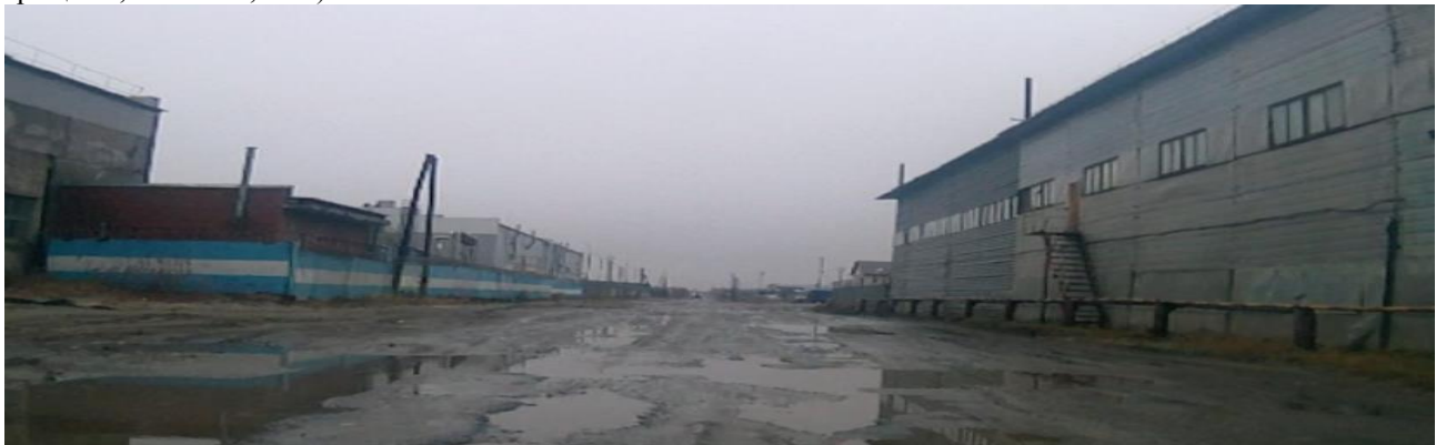
Рисунок 13. Автопроезд к ОРС-2. Ярко выраженные дефекты покрытия (выбоины, ямы). Отсутствие водоотвода с проезжей части и нарушение вертикальной планировки. Отсутствие пешеходной зоны
