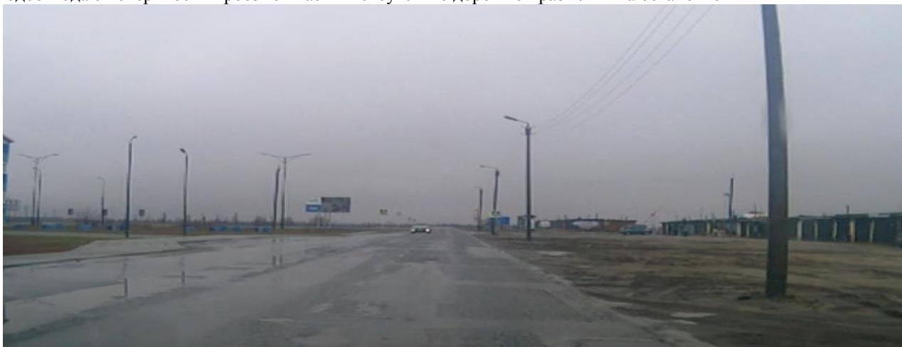
Рисунок 5. Улица Мира. Отсутствие тротуаров и бордюрного камня справа. Отсутствие водоотвода с поверхности проезжей части
