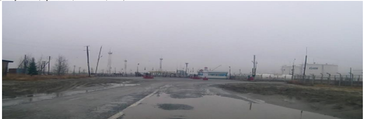
Рисунок 12. Автопроезд к ОРС-2. Ярко выраженные дефекты покрытия (шелушение, раскрашивание, трещины, выбоины, ямы)
