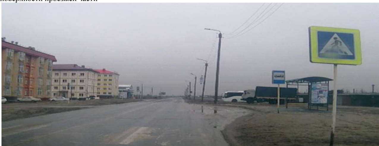
Рисунок 4. Улица Мира. Отсутствие тротуаров подходящих к посадочной площадке. Отсутствие водоотвода с поверхности проезжей части и отсутствие дорожной разметки на остановке
