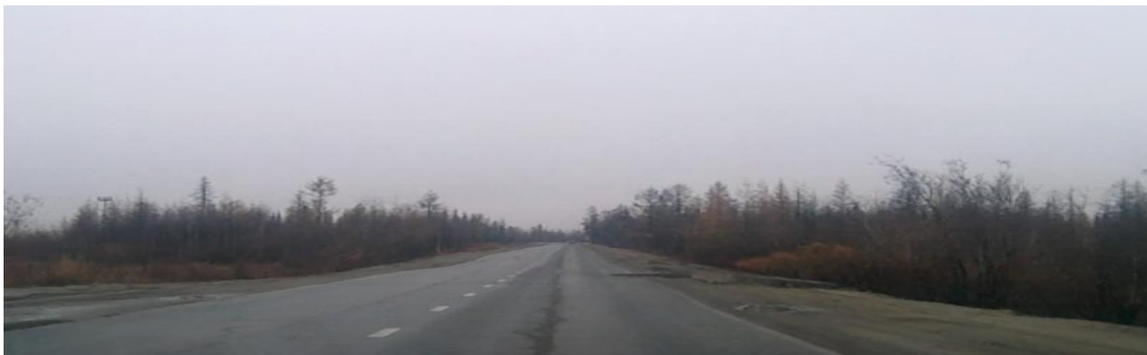
Рисунок 14. Автопроезд к ОРС-2. Дорога проходит в невысокой насыпи. Отсутствует укрепление обочин. Отсутствуют ограждающие и направляющие устройства. Откосы насыпи имеют дефекты: наличие кустарника
