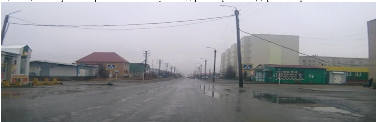
Рисунок 8. Улица Звездная. Отсутствие тротуаров и бордюрного камня. Отсутствие водоотвода с поверхности проезжей части. Отсутствие дорожной разметки. Ярко выраженные дефекты покрытия (шелушение, раскрашивание, развитие выбоин)
