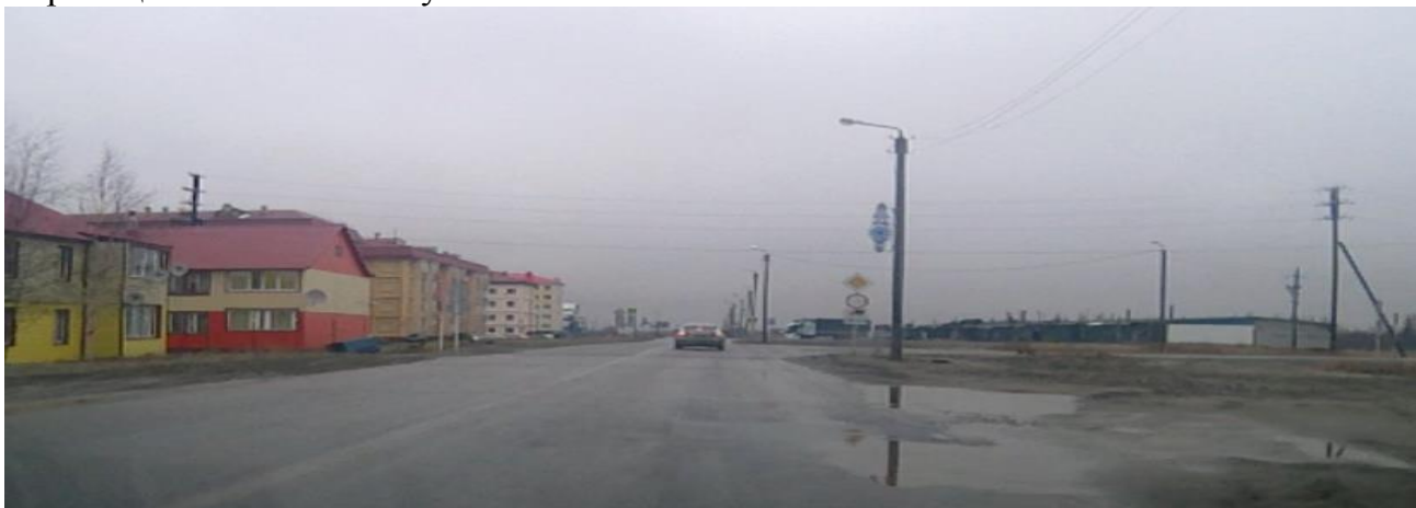
Рисунок 3. Улица Мира. Отсутствие тротуаров и бордюрного камня. Отсутствие водоотвода с поверхности проезжей части
