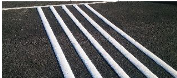
Рисунок 57. Шумовая полоса из термопластика
