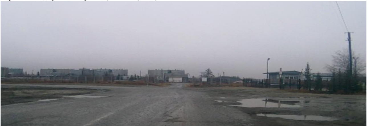
Рисунок 11. Автопроезд к ОРС-2. Отсутствие тротуаров и бордюрного камня. Отсутствие водоотвода с поверхности проезжей части. Нарушение вертикальной планировки. Ярко выраженные дефекты покрытия (шелушение, трещины, выбоины, ямы)
