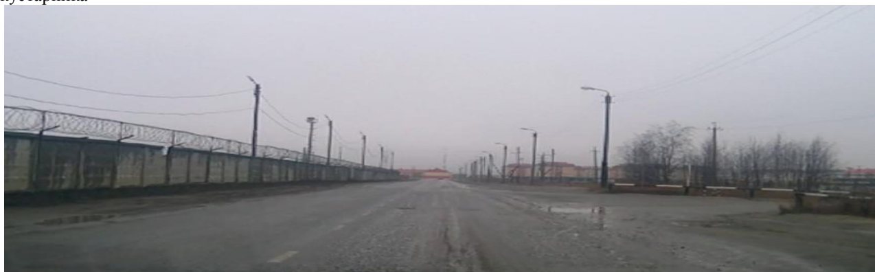
Рисунок 15. Автодорога Аэропорт-ПК 0 Ярko выраженные дефекты покрытия (шелушение, раскрашивание, выбоины, ямы). Отсутствие пешеходной зоны
