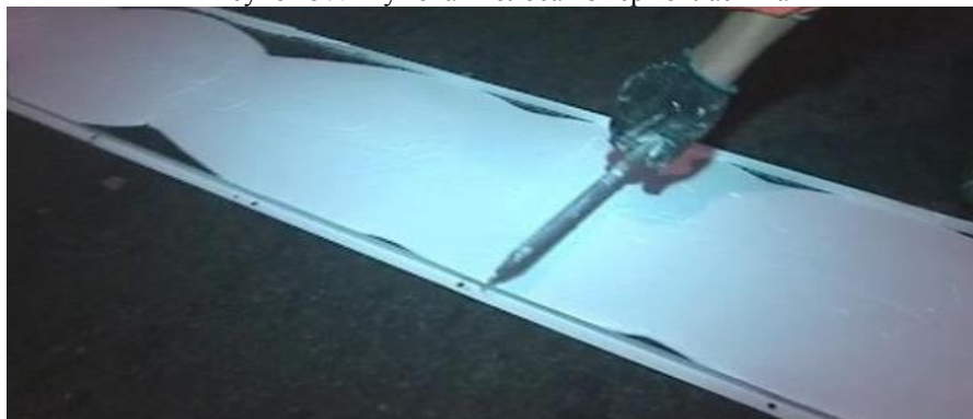
Рисунок 58. Устройство шумовой полосы путем наклейки на покрытие поперечных линий из пластичных материалов
