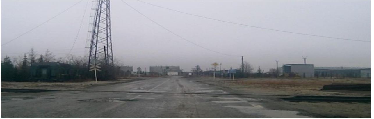
Рисунок 10. Автопроезд к ОРС-2. Нерегулируемый железнодорожный переезд в одном уровне. Ярко выраженные дефекты покрытия (выбоины, ямы)
