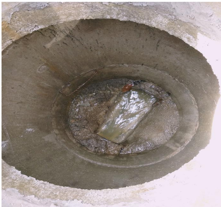
Рисунок 4.2 Колодец сборного коллектора диаметром 450 мм
